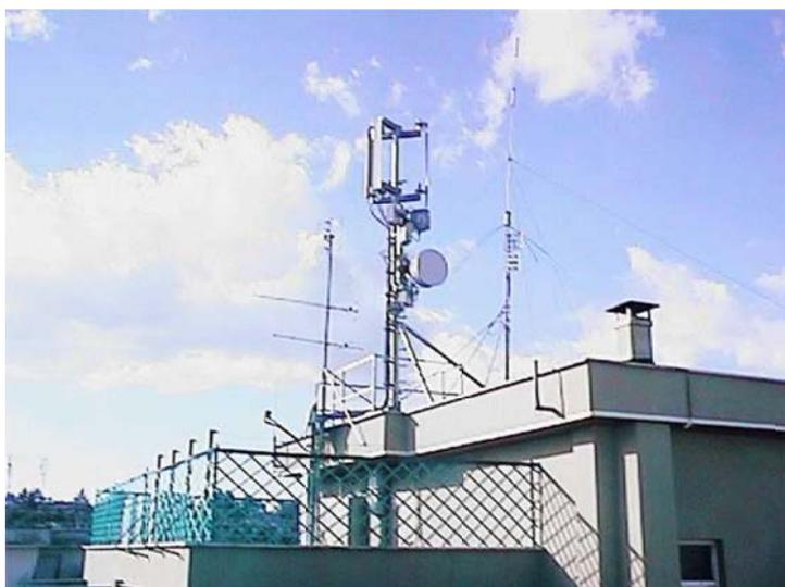
Nel caso delle antenne, il campo può essere diminuito riducendo la potenza dell'antenna. Si può agire anche aumentando l'altezza o modificando il tilt dell' antenna.
